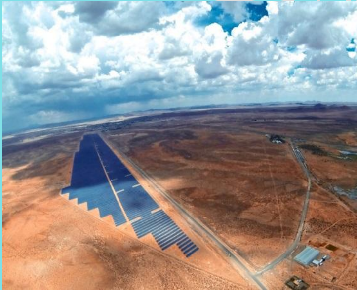
50MW De Aar Solar PV
